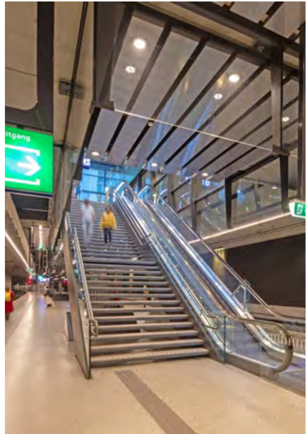
Op het midden bordes van de trap was te weinig licht. Hier zijn nu (achter de lamellen) extra spots geplaatst.
