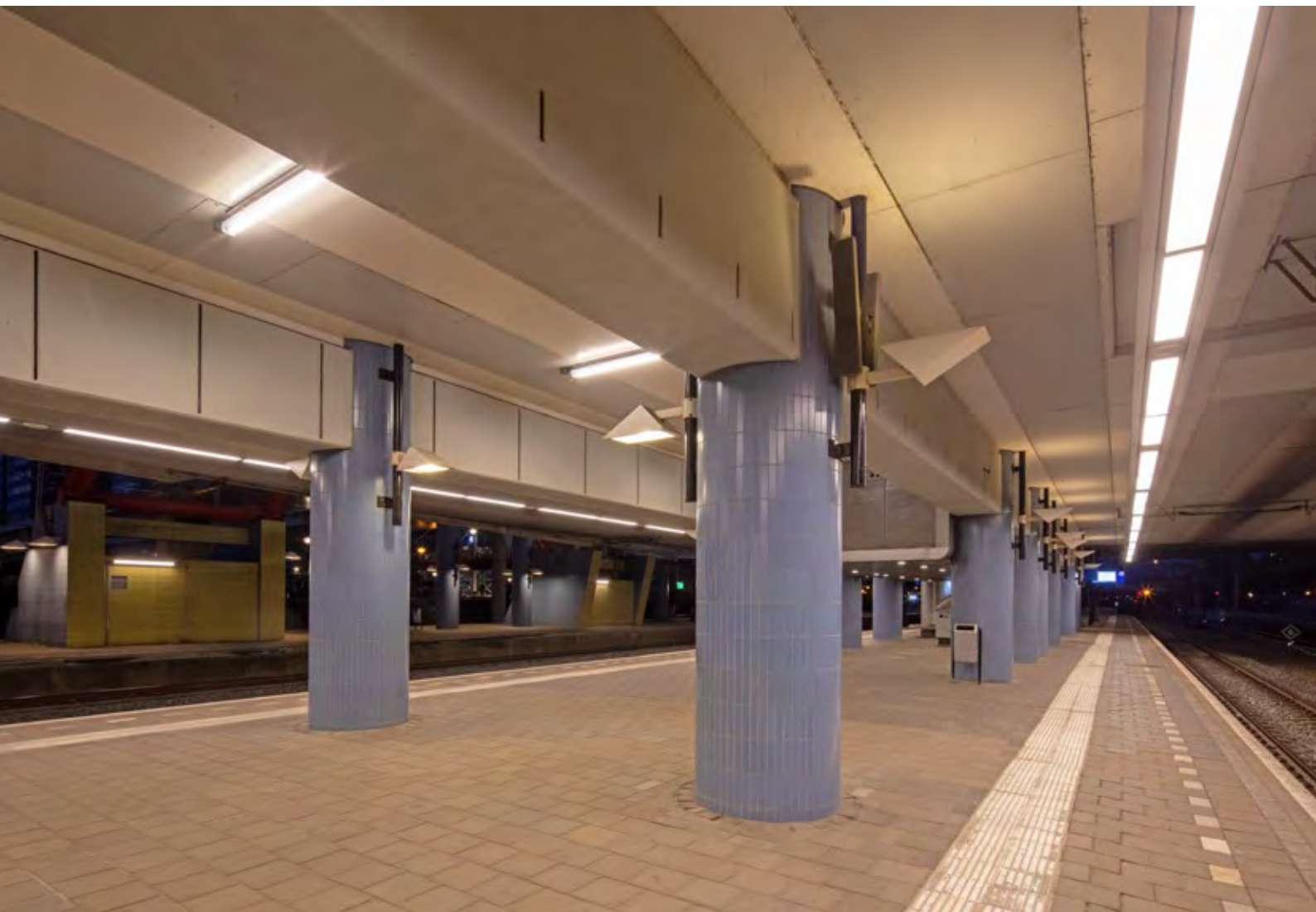
Ledverlichting op station Amsterdam Sloterdijk
