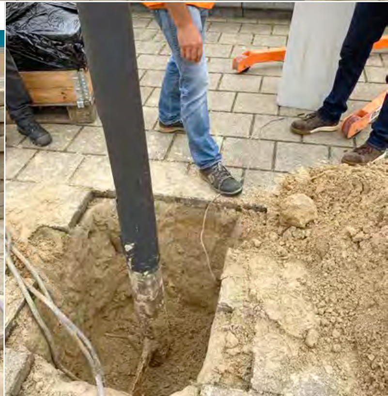
De oude kabel is open gegraven bij de oude mast.
