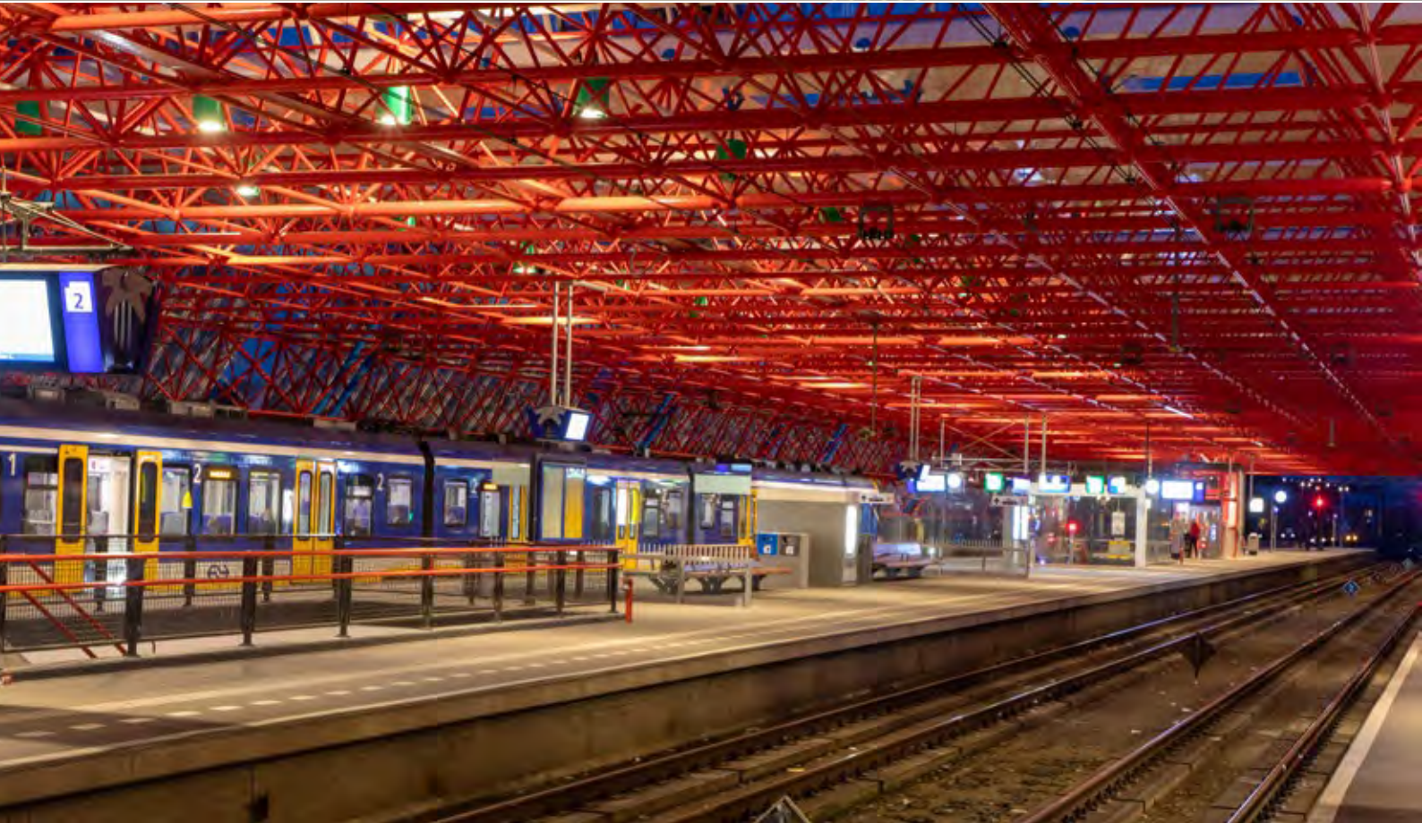
Boven het vlekkerige licht op een perron van station Almere Centrum in 2016. Onder de nieuwe situatie met veel hogere verlichtingssterkte en een betere gelijkmatigheid.
