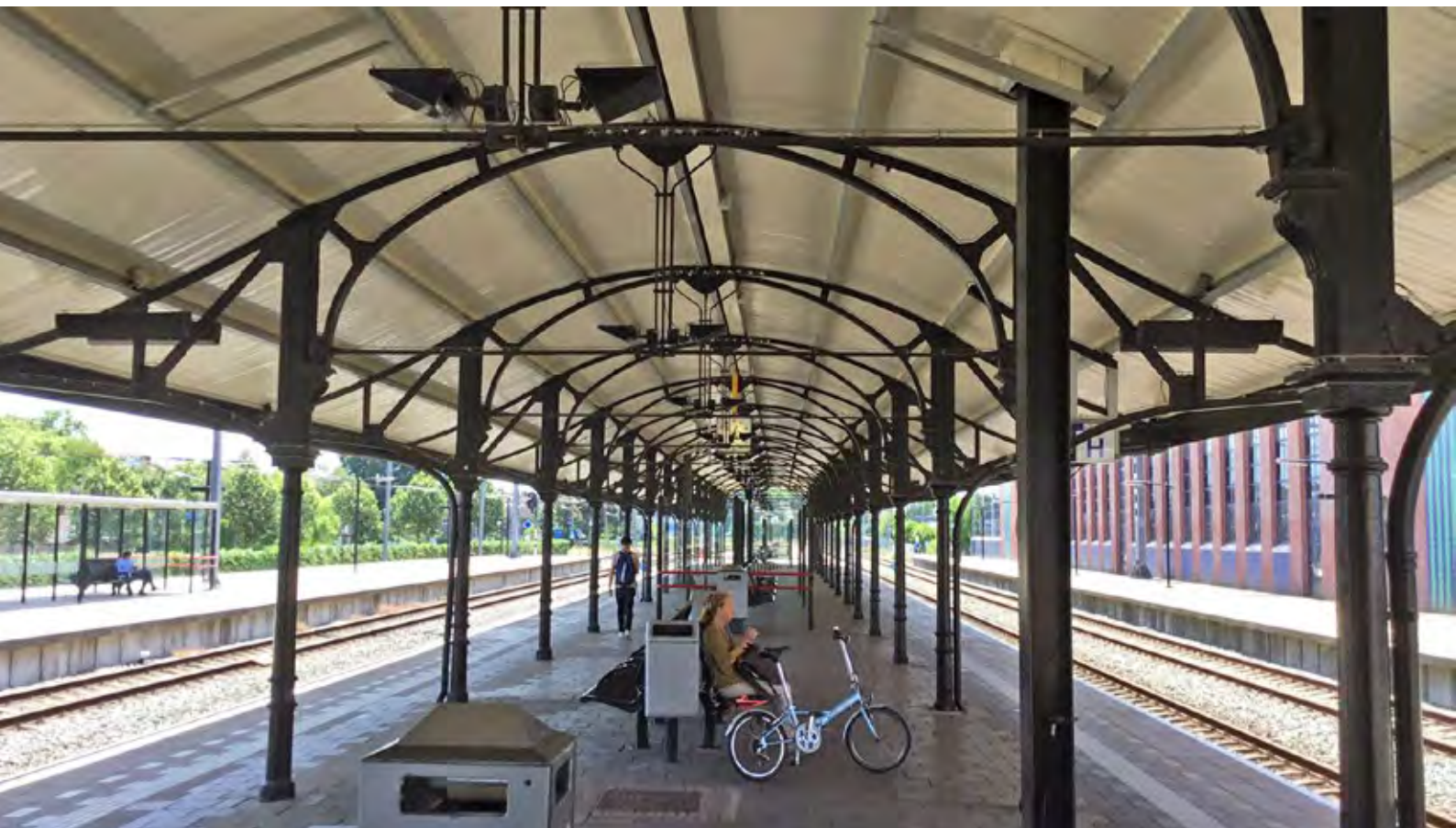
De oude uplighters op station Hilversum met horizontale ruit en anti duiven schrikdraad installatie.
