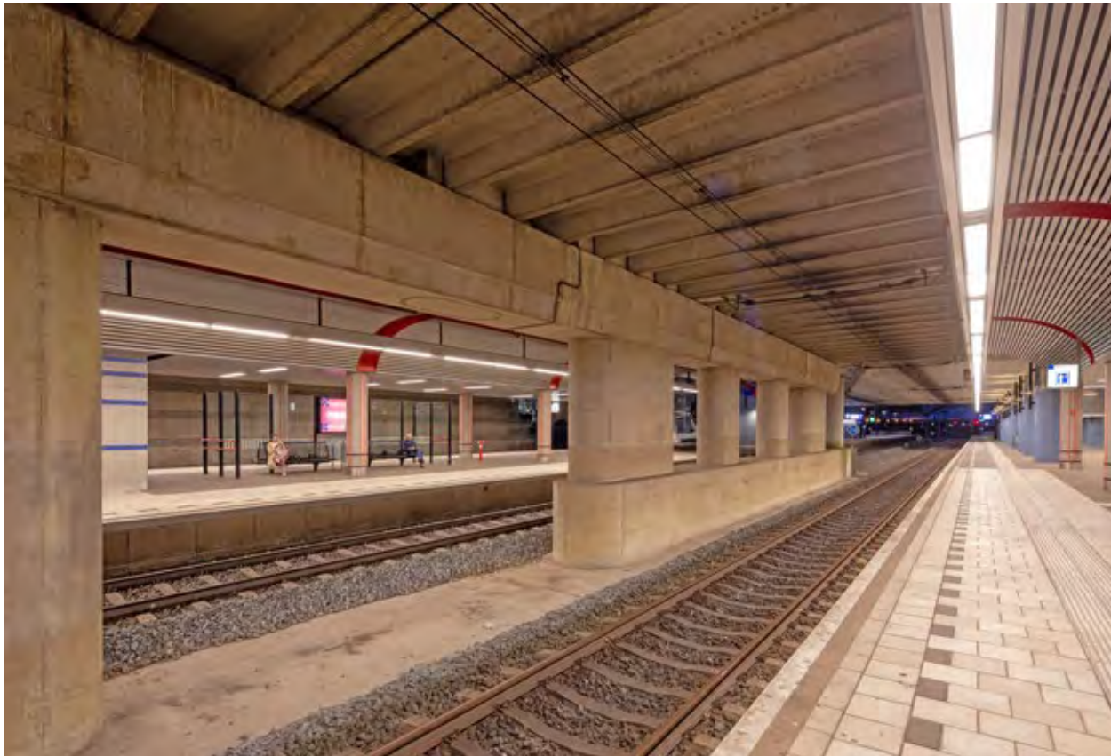
De volledig omsloten perrons op station Amsterdam Sloterdijk met 200 lux in de avond na de led vervanging.
