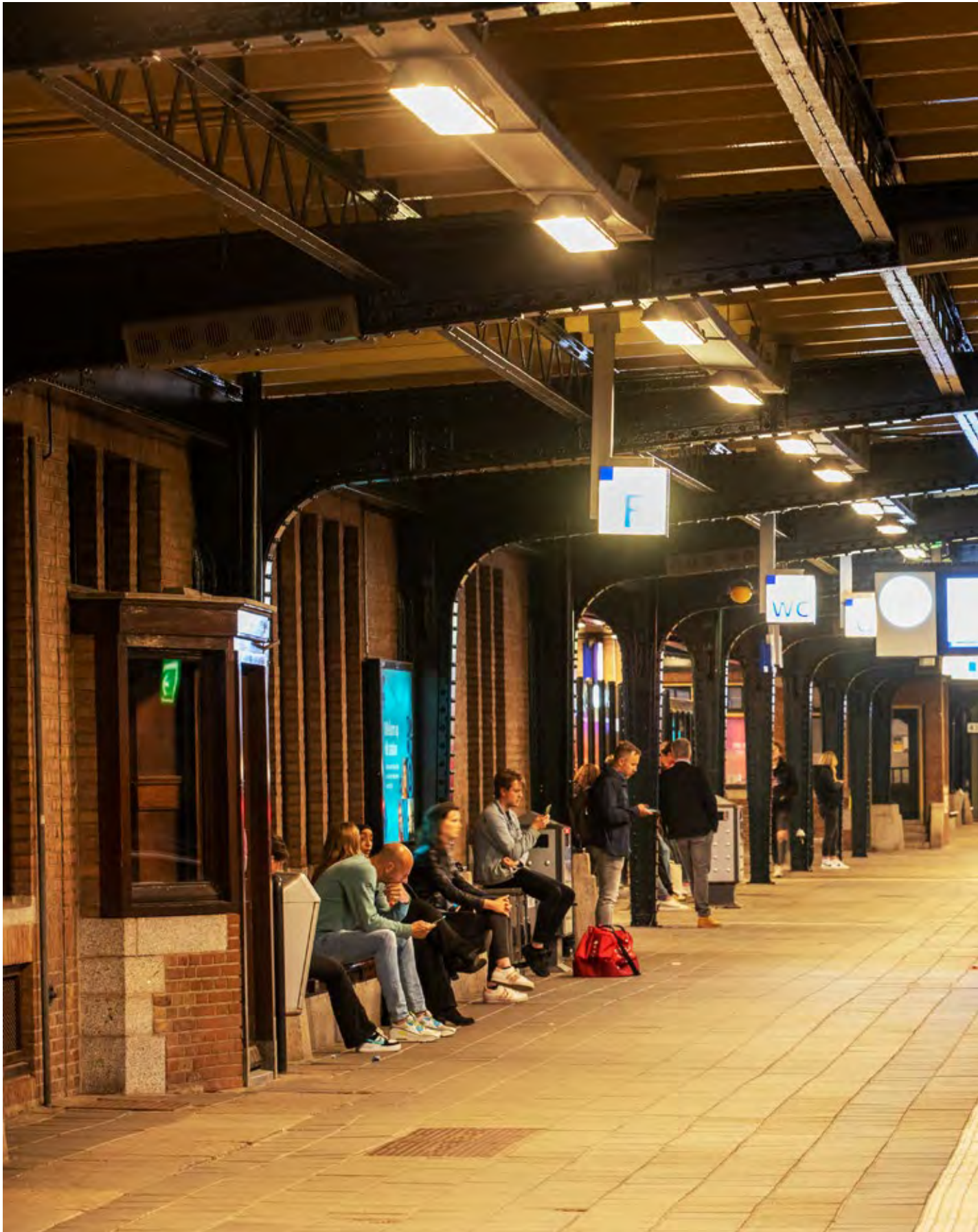
De armaturen met platte kappen boven het perron in Deventer na de led vervanging
