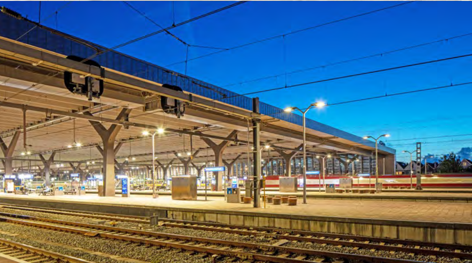
Masten buiten de kap.
