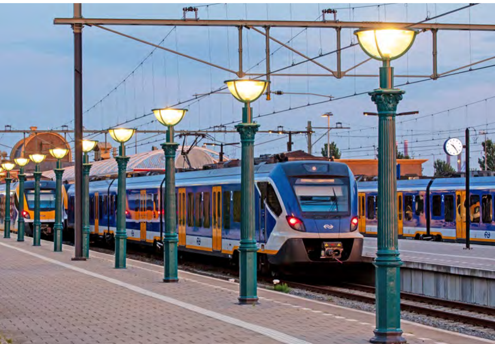
Historische gietijzeren lichtmasten op station Vlissingen voorzien van maatwerk led armaturen en nieuwe heldere kappen.
