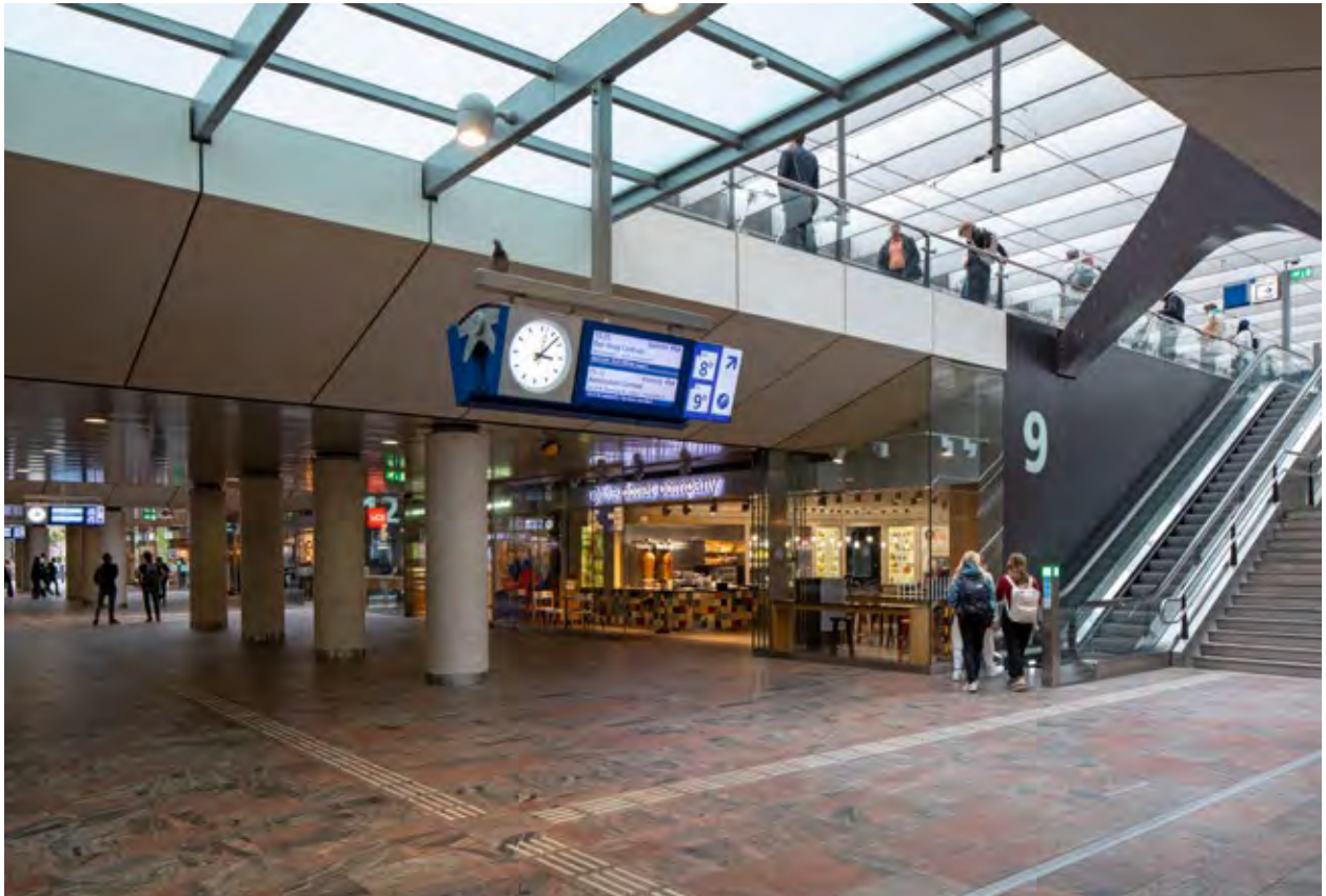
In de passage zijn donkere vlekken tussen de kolommen.
