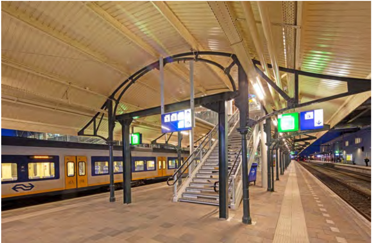
De monumentale kap met de nieuwe ledverlichting onder de nieuwe kabelgoot.
