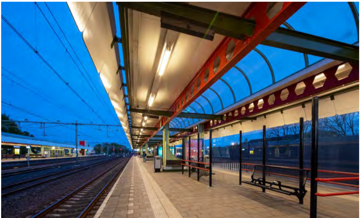
Station Weesp. Ledlampen geven warmer licht dan TL waardoor stations prettiger aanvoelt. De lichtlijn is naar binnen verplaatst waardoor het midden van het perron minder somber is. In Weesp heeft de architect in de jaren '70 ook al de regel daglicht tenzij toegepast door het middelste deel van de kap transparant te maken.
