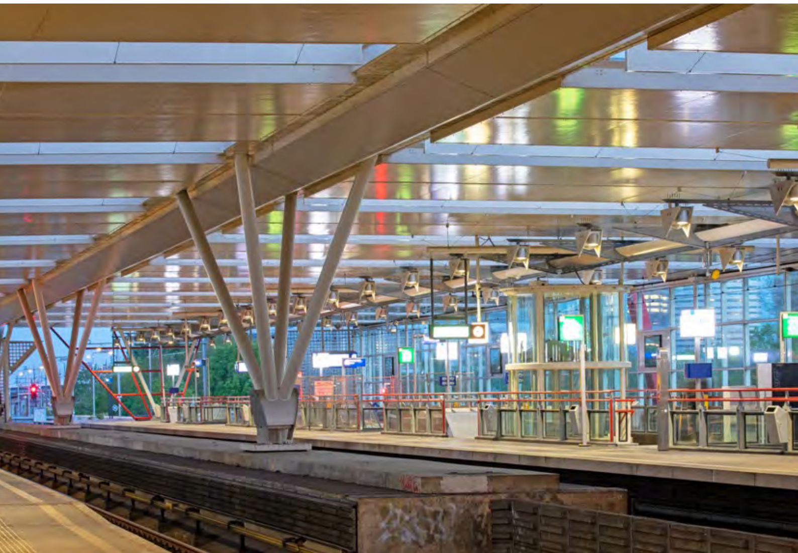
De spots tussen de driehoeken zijn omgebouwd met een nieuw led binnenwerk.
