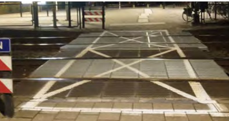
Op het overpad zijn geen donkere vlekken te zien.
