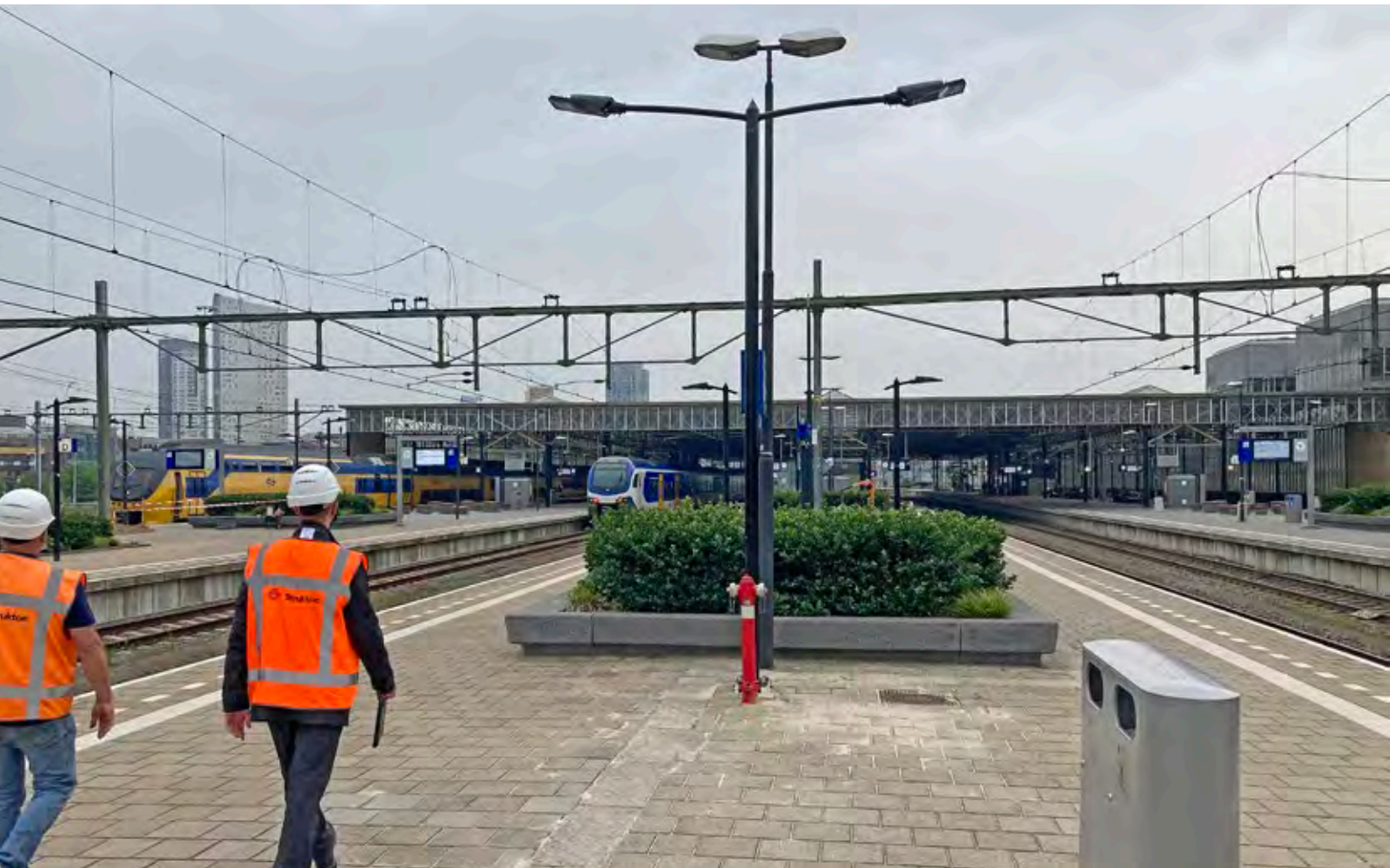
De nieuwe mast is al geplaatst terwijl de oude nog gerooid moet worden.
