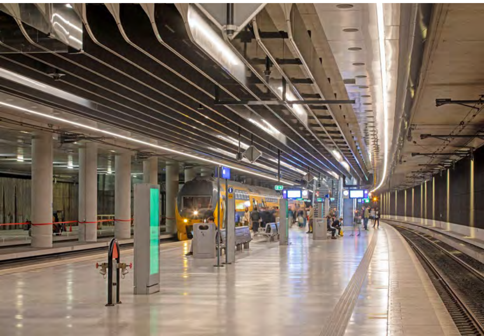
Ledverlichting op het perron van station Delft
