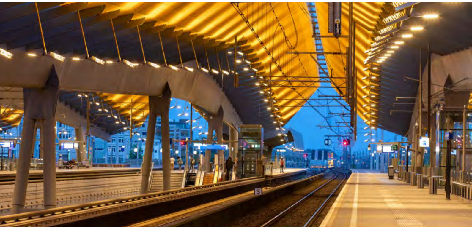
Het golvende dak met de up- en downlighters is na de ledvervanging weer goed te zien.
