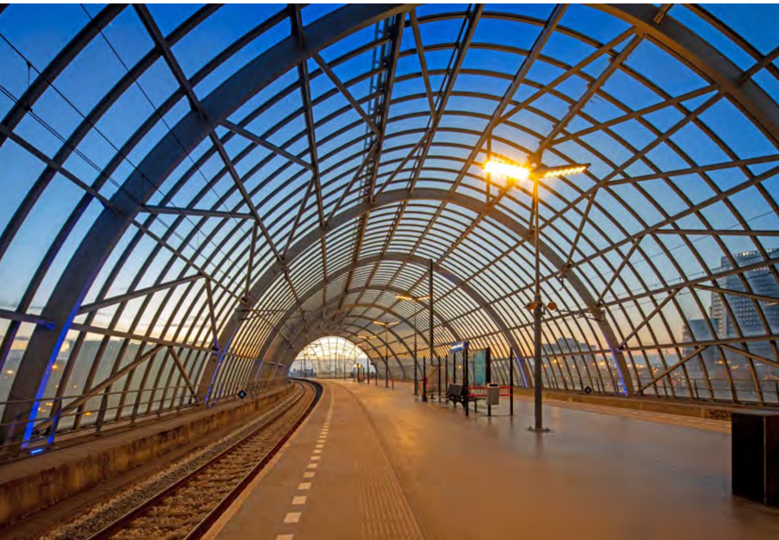
Station Amsterdam Sloterdijk Hemboog. De architect wil de bogen van de kap niet verstoren met armaturen en heeft voor lichtmasten onder de kap gekozen. Om verblinding te voorkomen zijn hogere masten toegepast dan op normale perrons.
