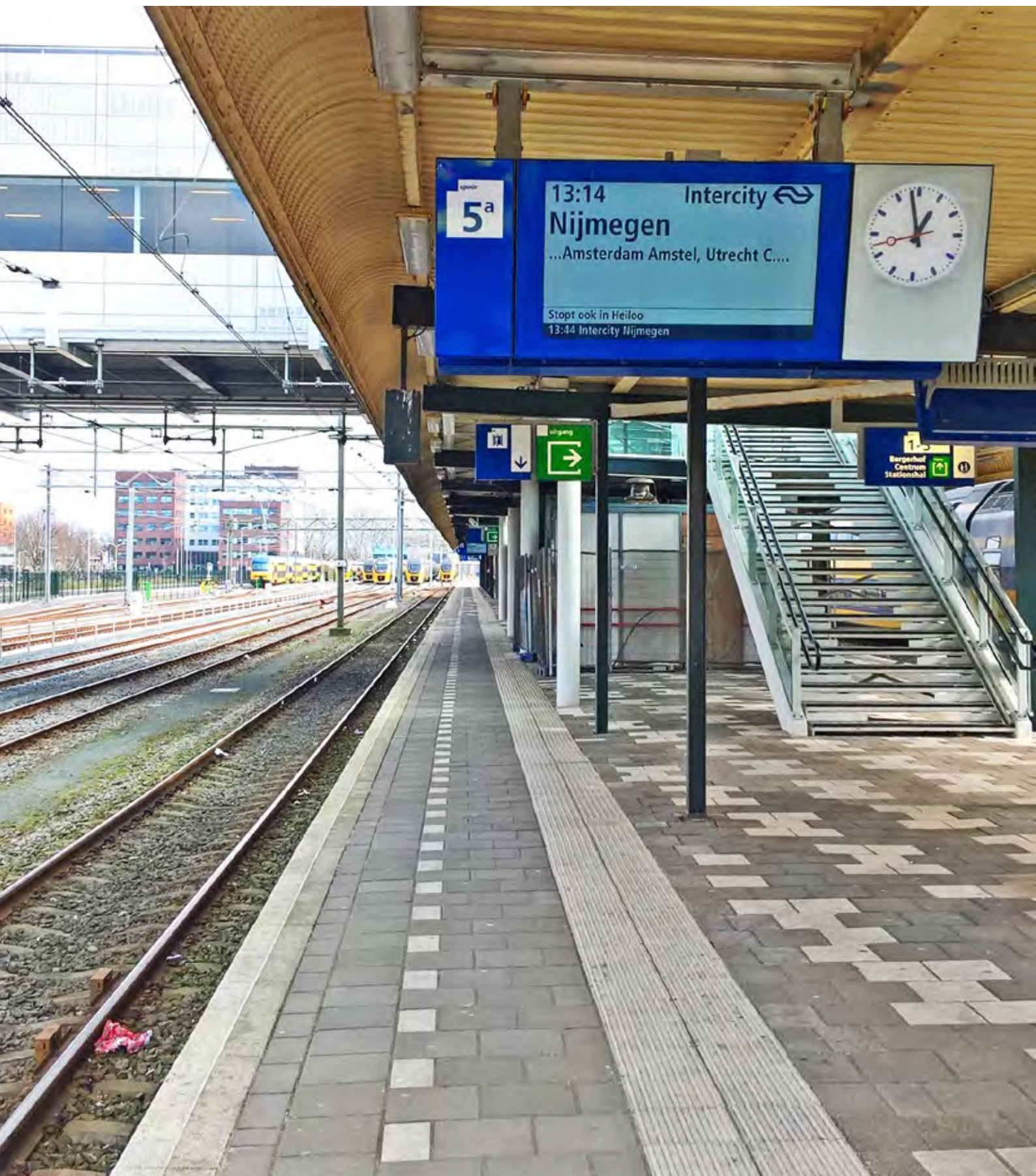
Station Alkmaar de oude situatie met de oude armaturen in zone A
