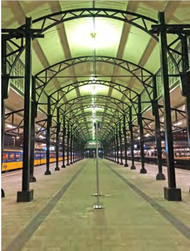
De kap van Amersfoort Centraal met de oude kwiklampen. De kelken passen bij de architectuur, maar geven groenig licht en zijn te dicht onder de kap geplaatst. De kap is hierdoor vlekkerig aangelicht.
